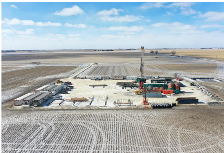
Рисунок 6 – Буровые работы компании по добыче природного «белого» водорода на землях фермеров Северной Америки Natural Hydrogen Energy [20]
